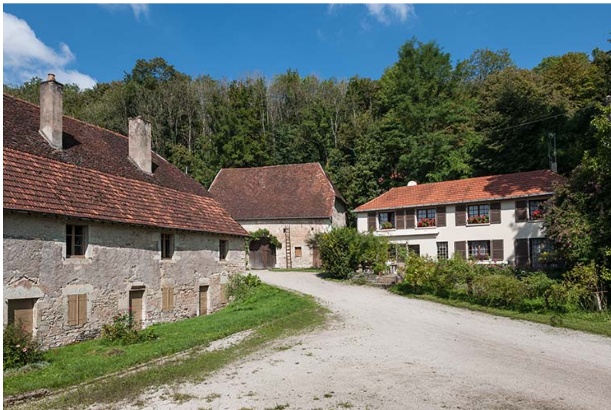
Logements depuis la cour.
