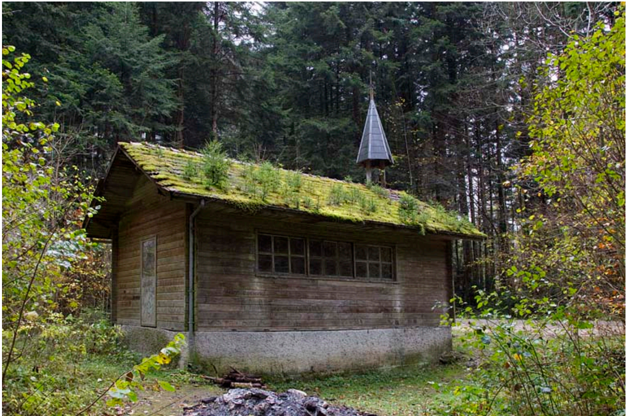
Chapelle, vue de trois quarts arrière gauche.
