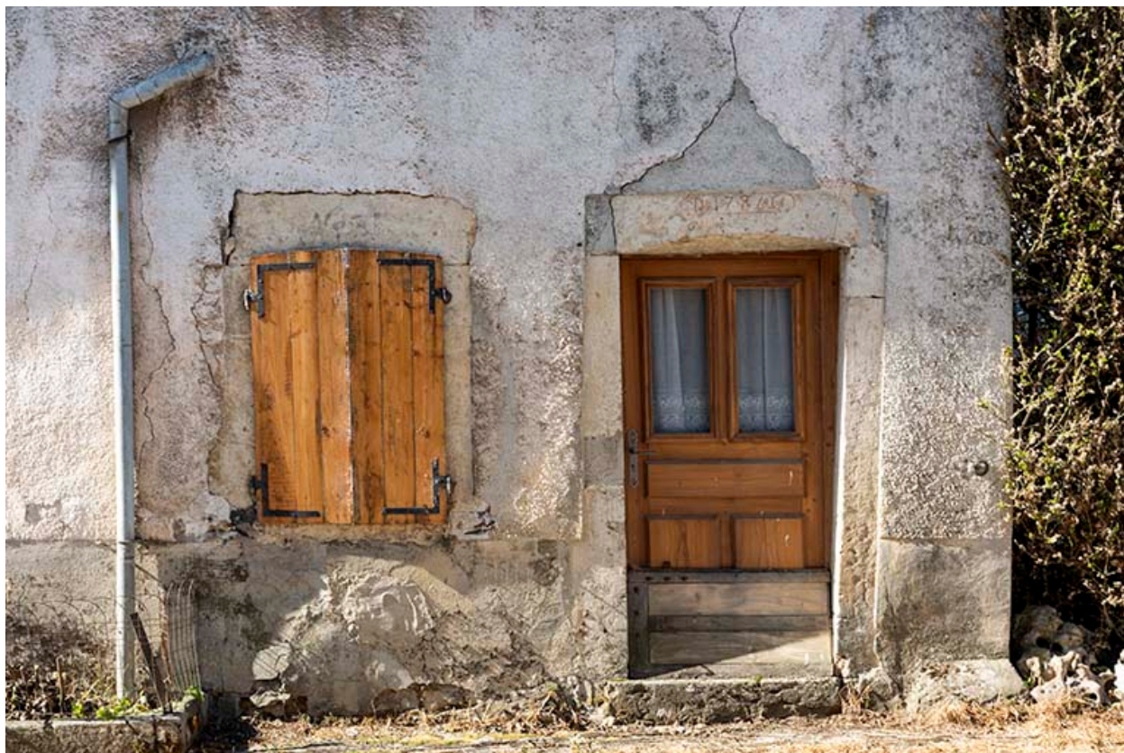
Maison de 1786, façade antérieure : porte et fenêtre.
