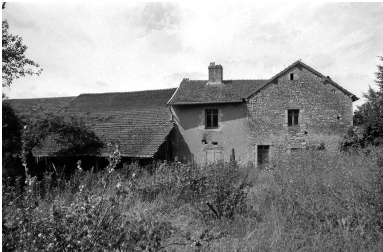
Façade postérieure de la partie gauche.
