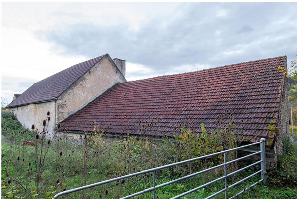
Le cuvage vu depuis le nord.
