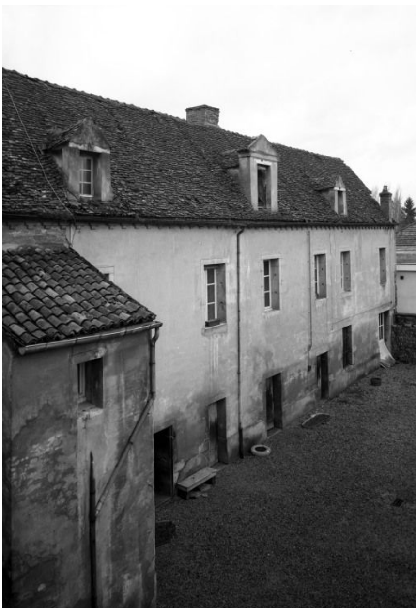
Ancien bâtiment des prisons, façade sur cour.
