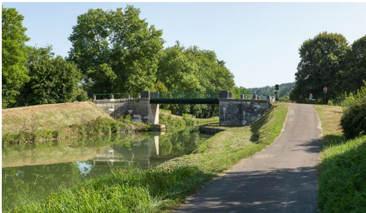
Vue d'aval du pont.
