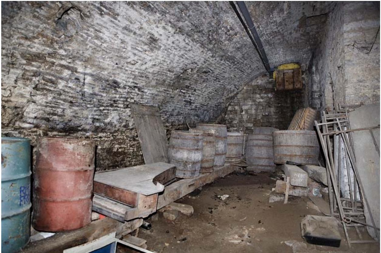
Intérieur, sous-sol : vue de la cave gauche, partie gauche.
