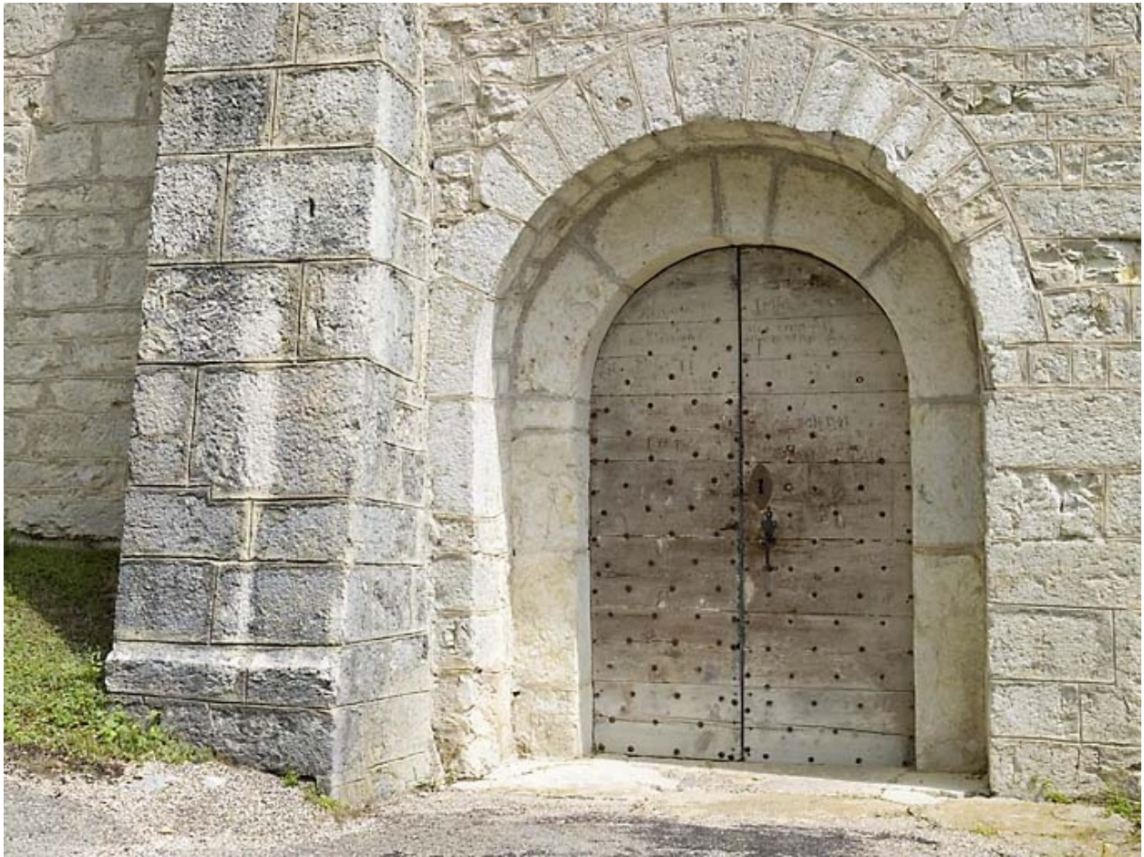
Façade sud : entrée.
