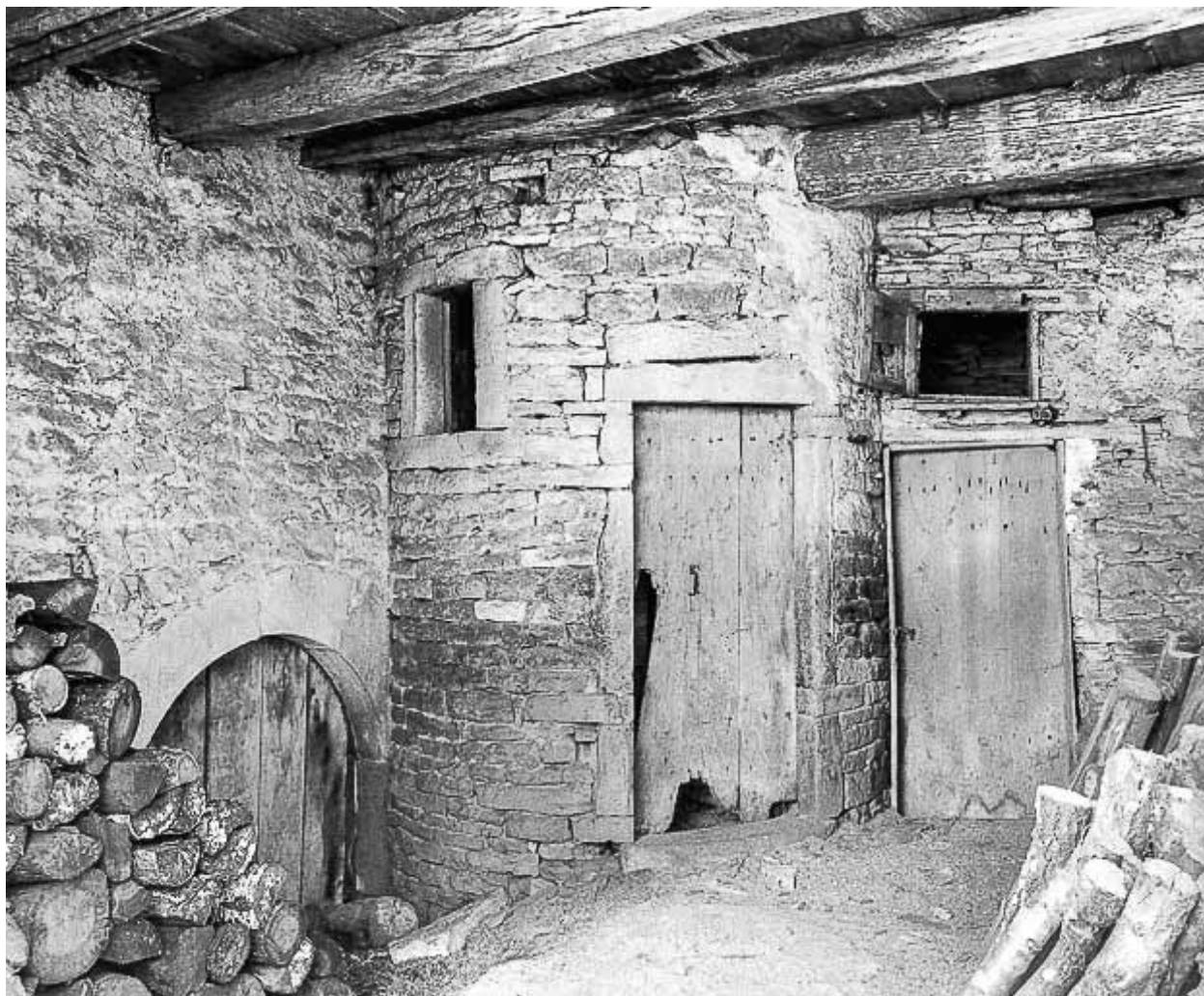
Sortie d'escalier et entrée de cave sous le hangar.
