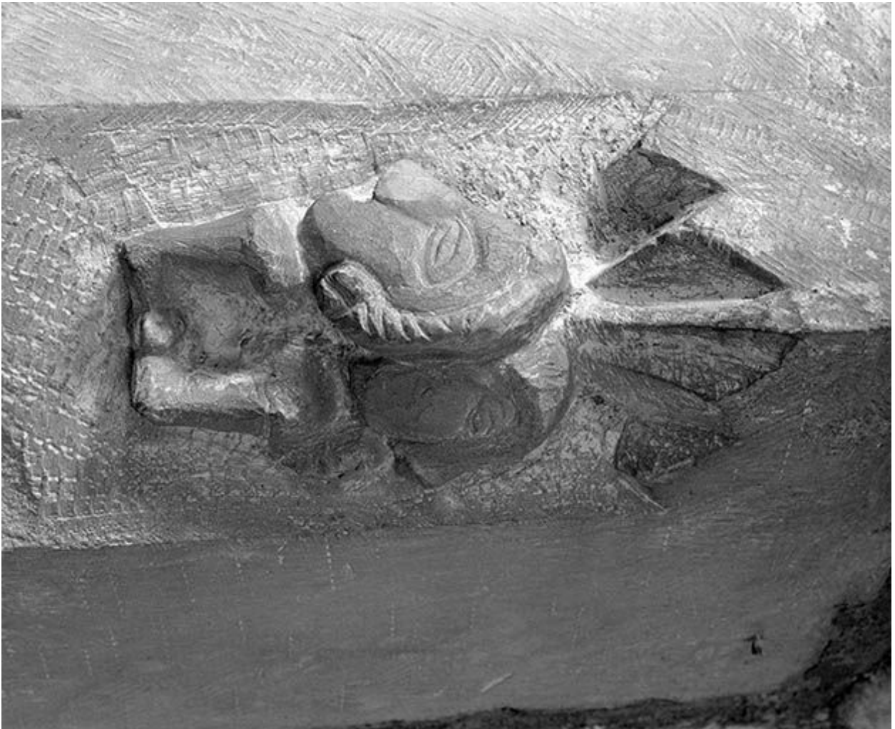
2ème pilier droit de la nef, angle postérieur droit.
