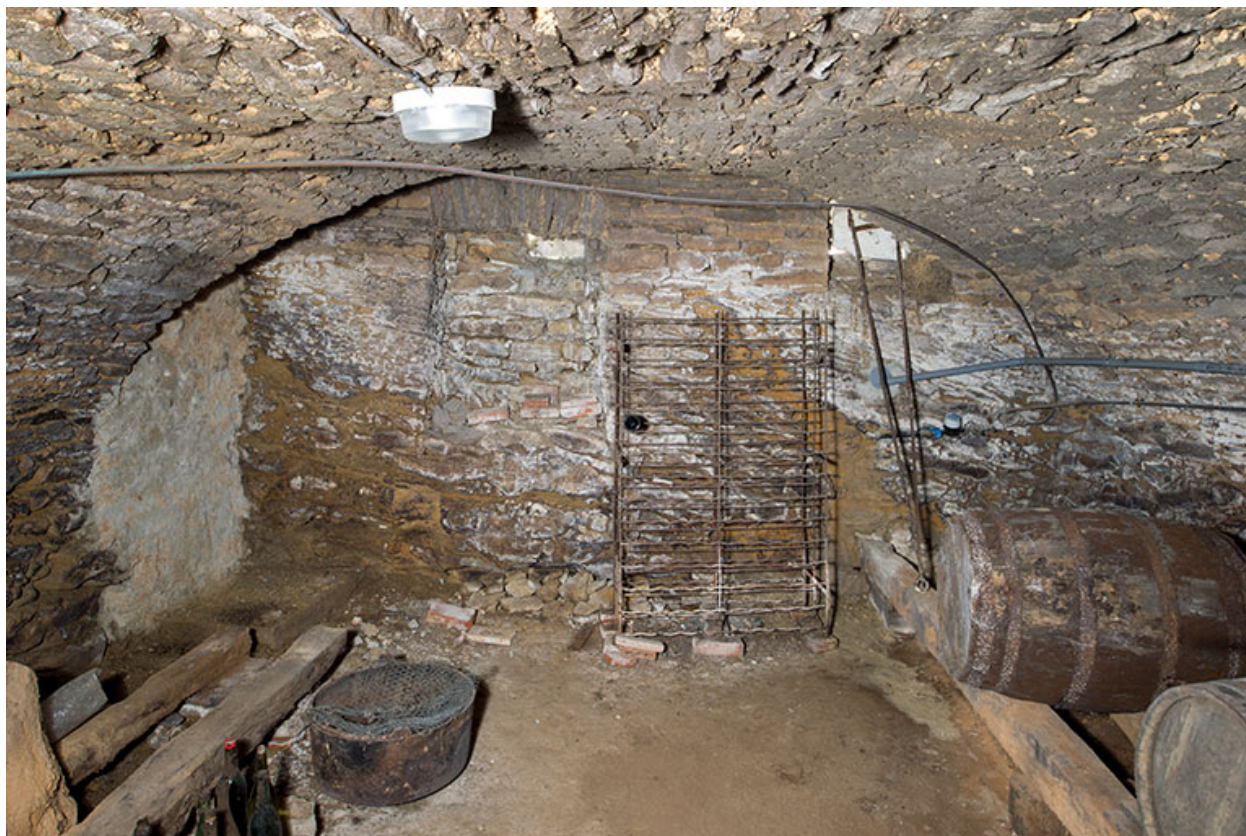
Le cellier ouest, depuis l'entrée.
