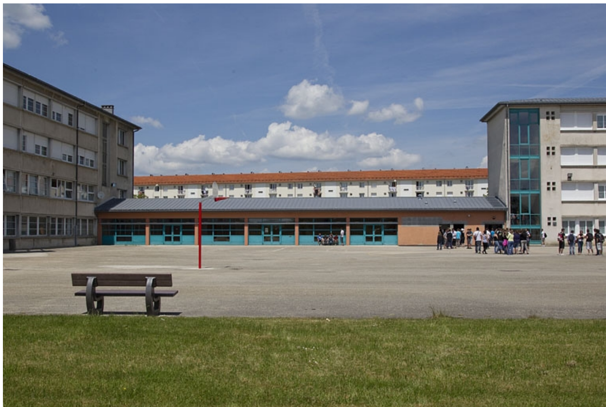
Bâtiment de l'administration : face postérieure.
