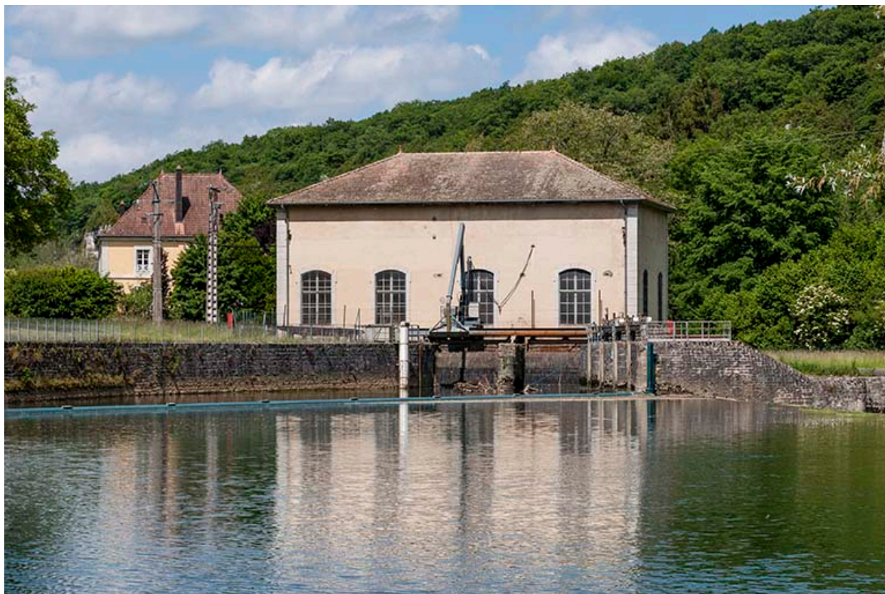
La centrale hydroélectrique vue depuis l'est.
