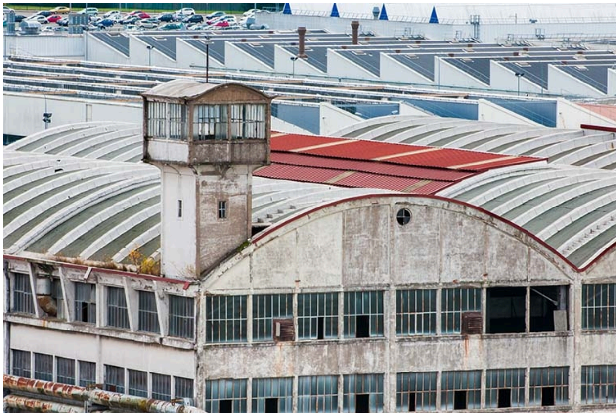
Toitures de l'usine Peugeot de Sochaux-Montbéliard.
