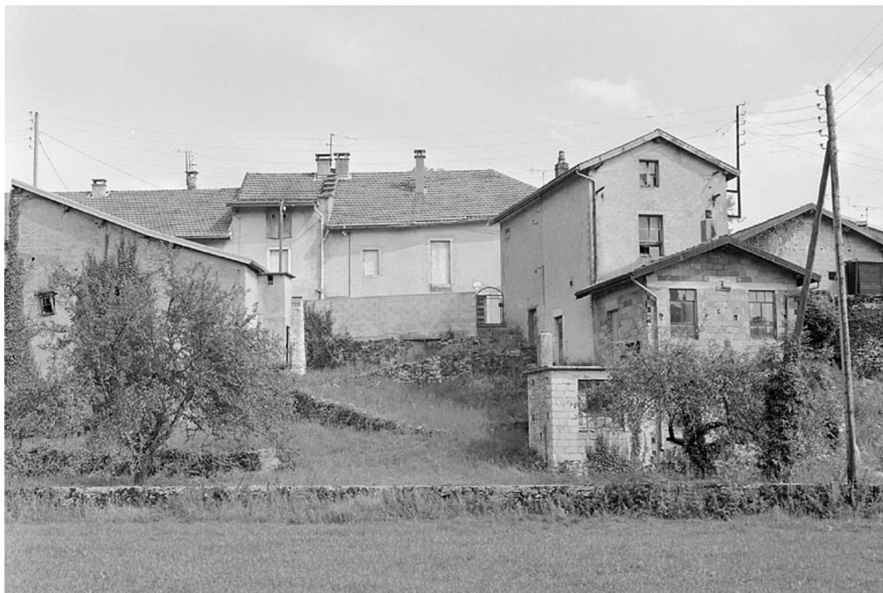
Vue postérieure de l'atelier de pipes.
