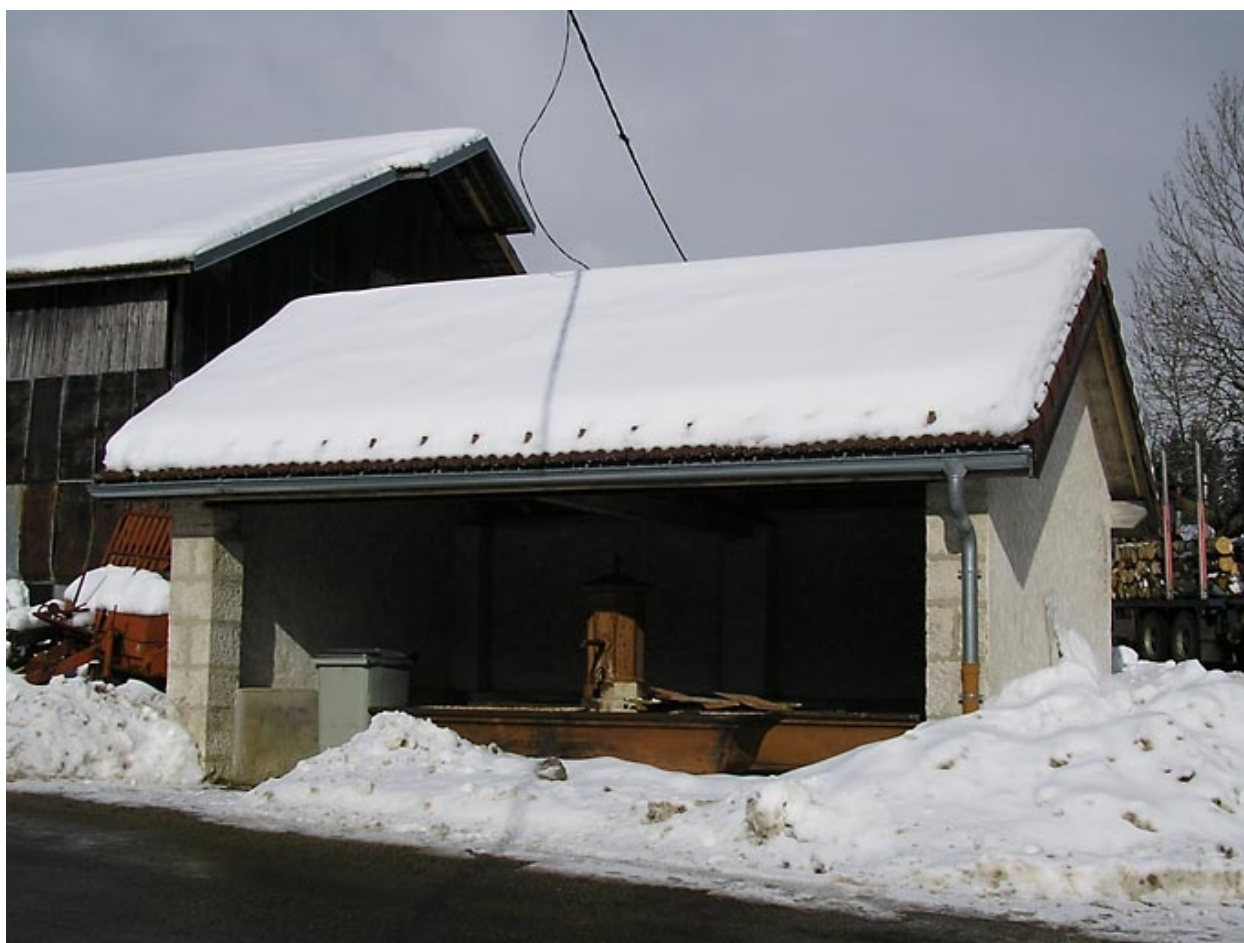
Fontaine-lavoir située au lieu-dit La Loye.
