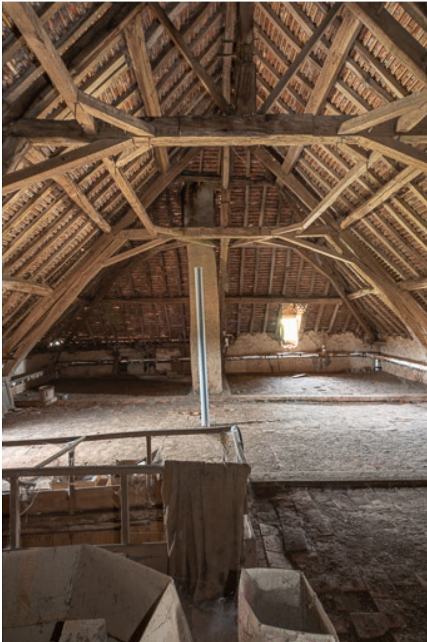
Vue de la charpente de la demeure
