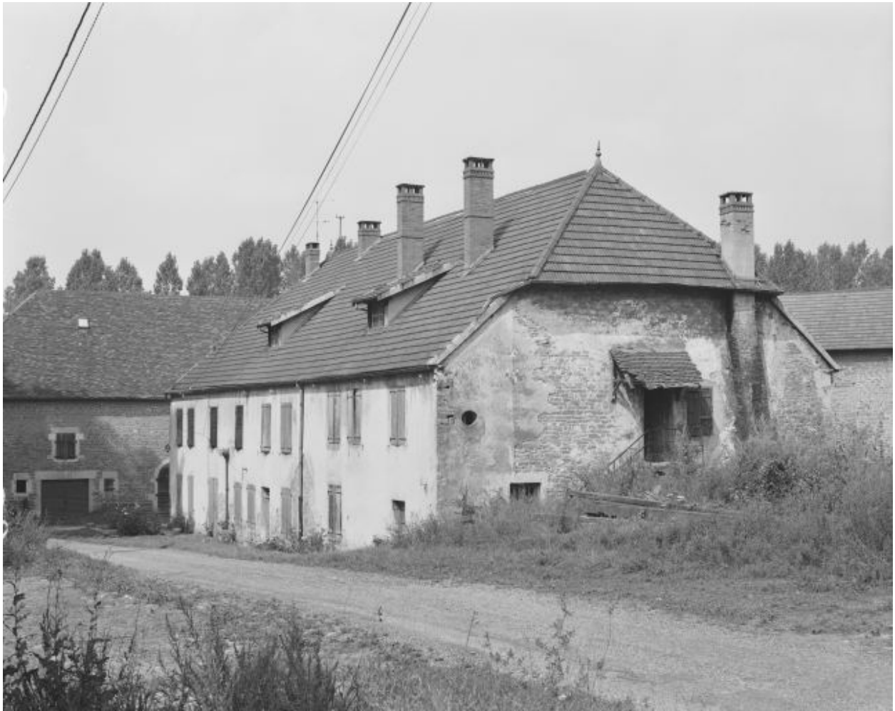
Logement patronal depuis le sud-ouest.
