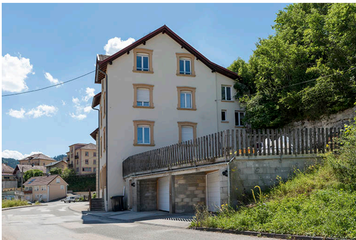
Façade latérale droite.
