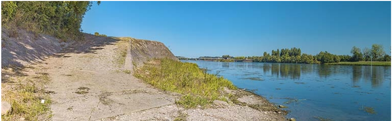
Rampe et perrés de la Mare-Jandeau.
