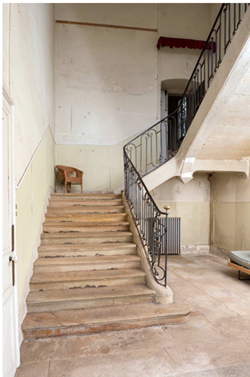
Vue de trois-quart de l'escalier principal.
