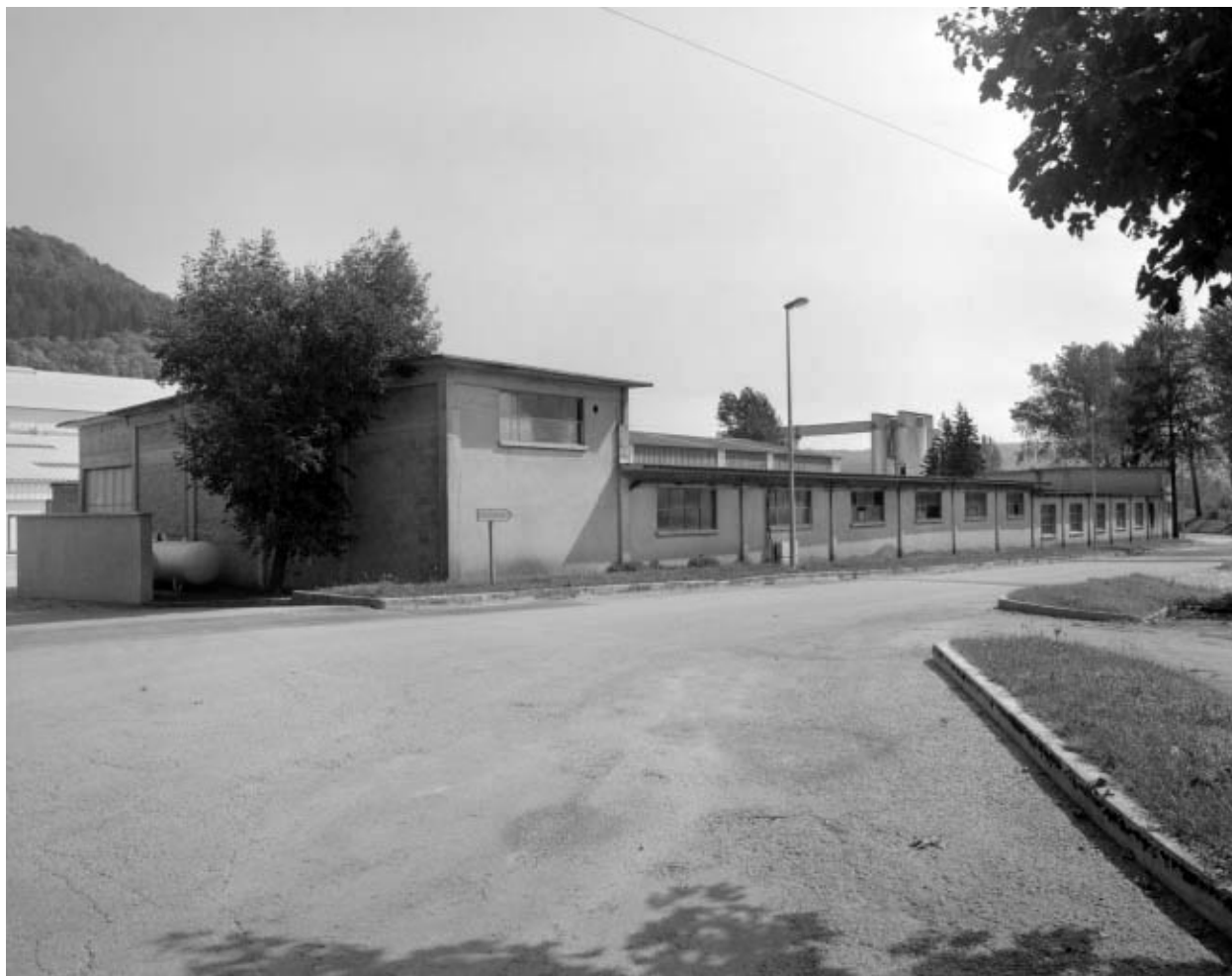
Façade ouest de l'atelier de réparation.
