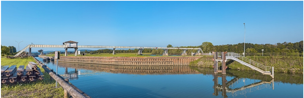
Tête amont de l'écluse.
