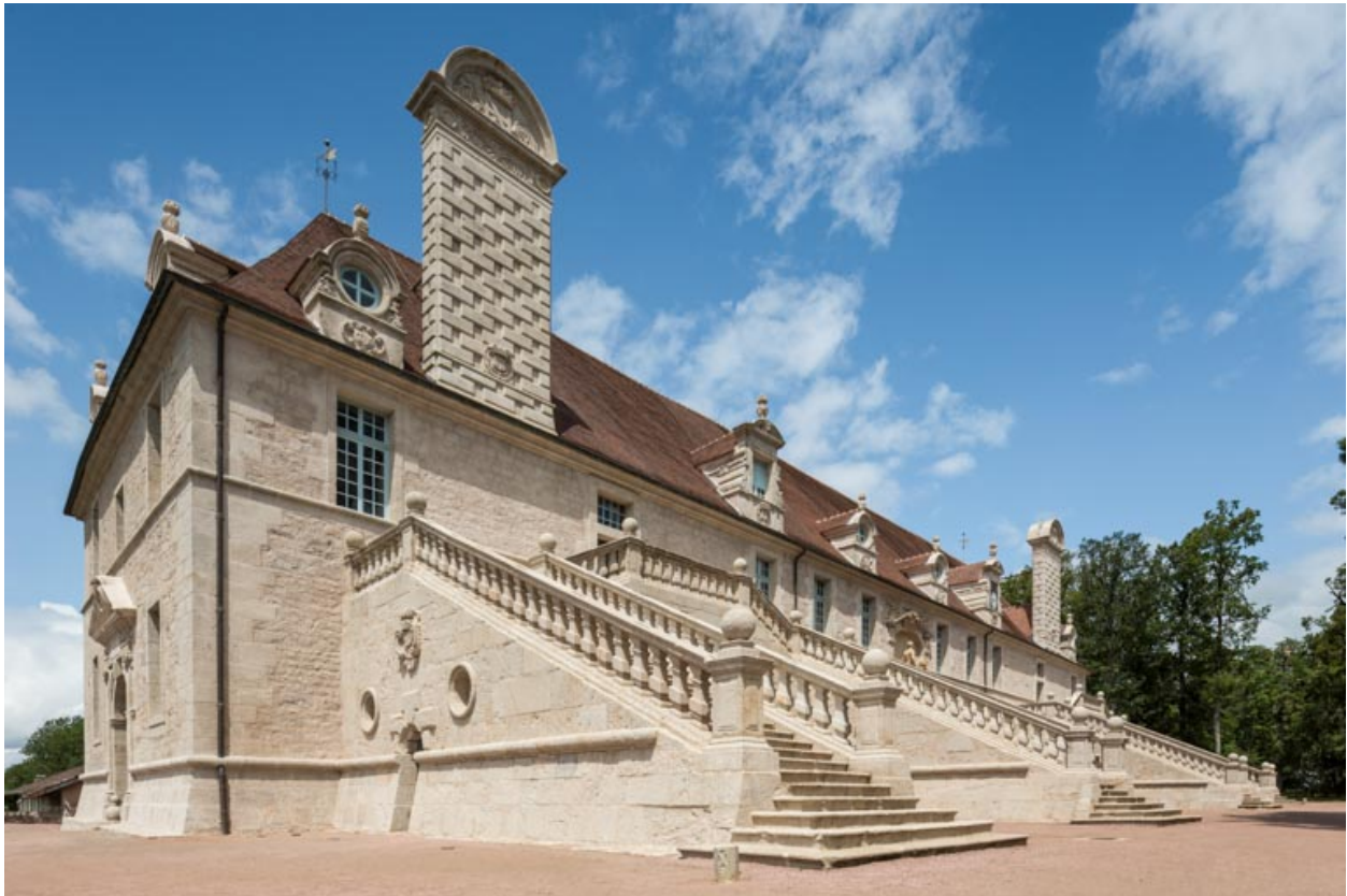
Façade sud-est, vue d'ensemble depuis le sud.
