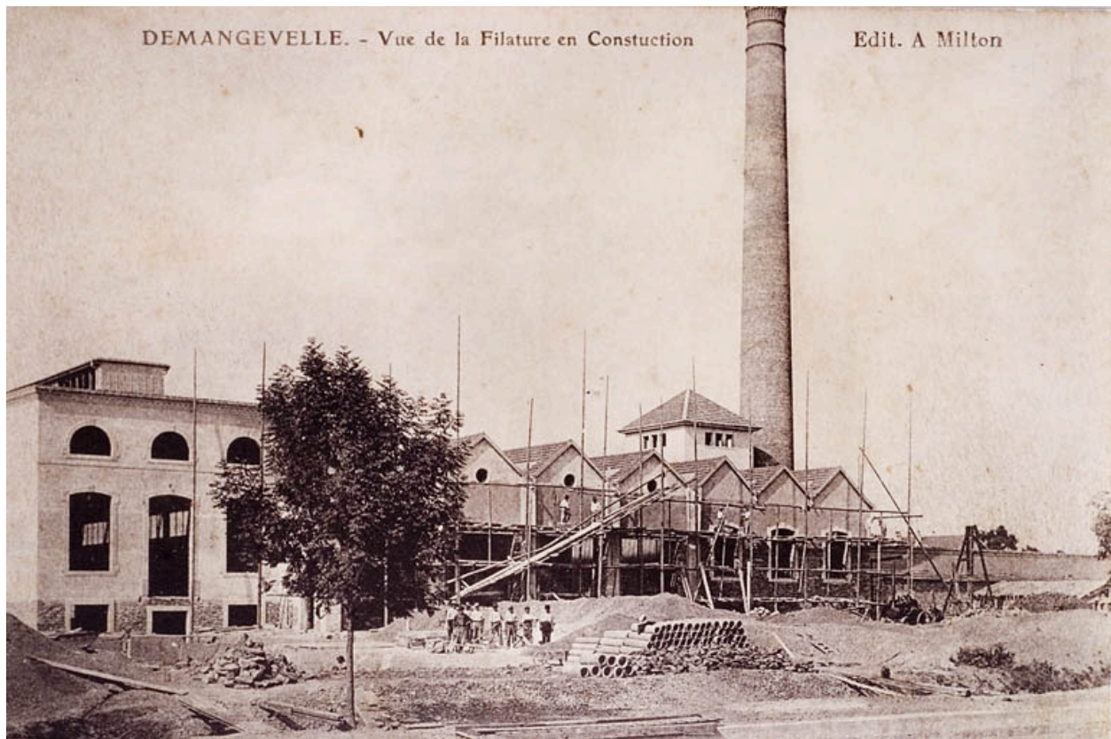
Demangevelle. - Vue de la filature en construction.
