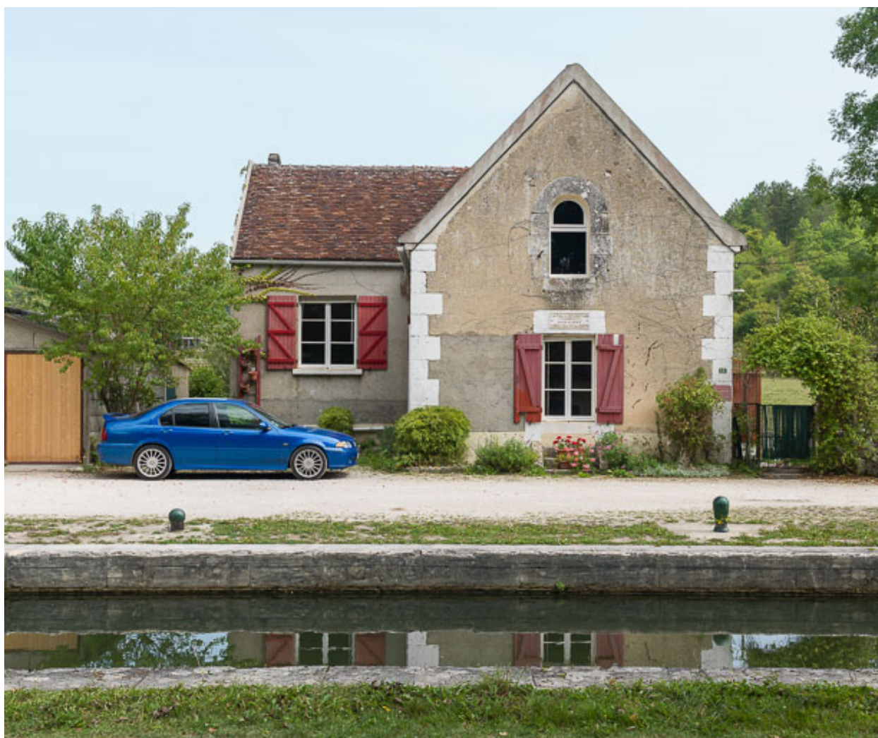
Vue de la maison éclusière.
