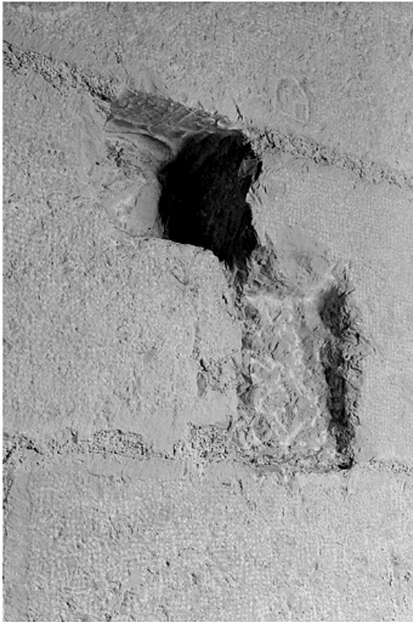
Trou de boulin dans la neuvième travée sud de la coursière de l'abside.
