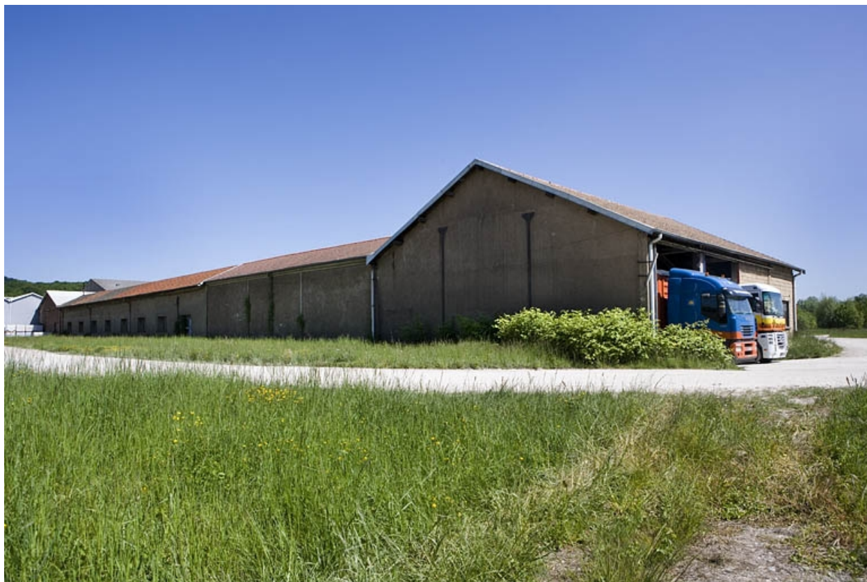
Magasin industriel. Pignon ouest.
