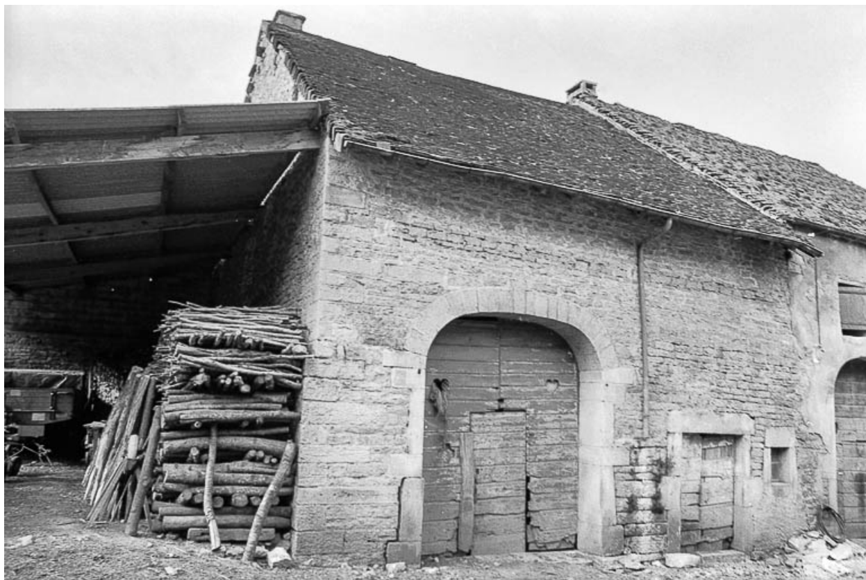
Ferme cadastrée D2 168 : façade antérieure.
