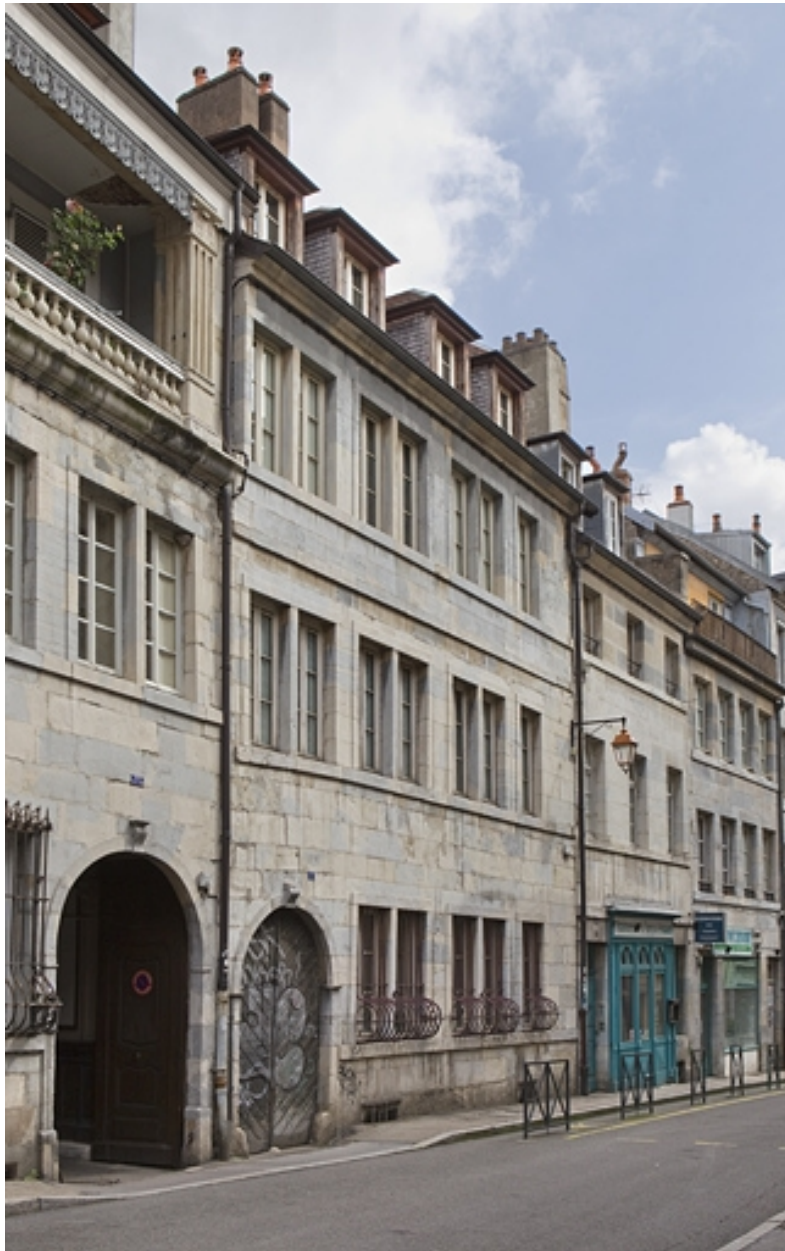
Vue d'ensemble du logis principal depuis la rue, de trois quarts gauche.
