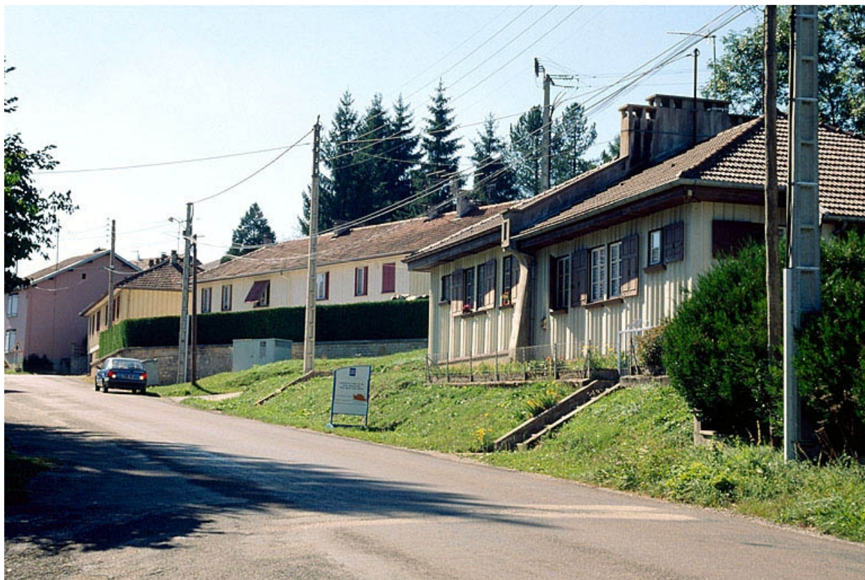
Vue d'ensemble des logements depuis l'est.
