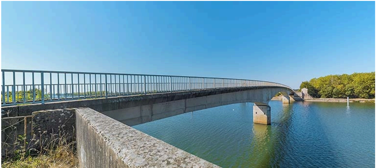
Vue d'ensemble du pont de Thorey depuis la culée de la rive gauche.
