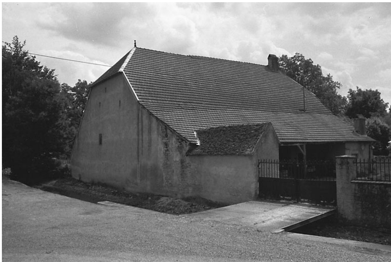
Façades antérieure et latérale gauche.
