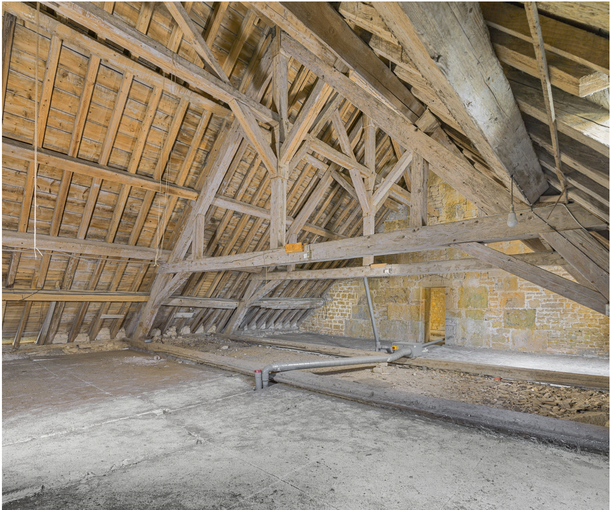
Caserne U, grenier : charpente du bâtiment.
