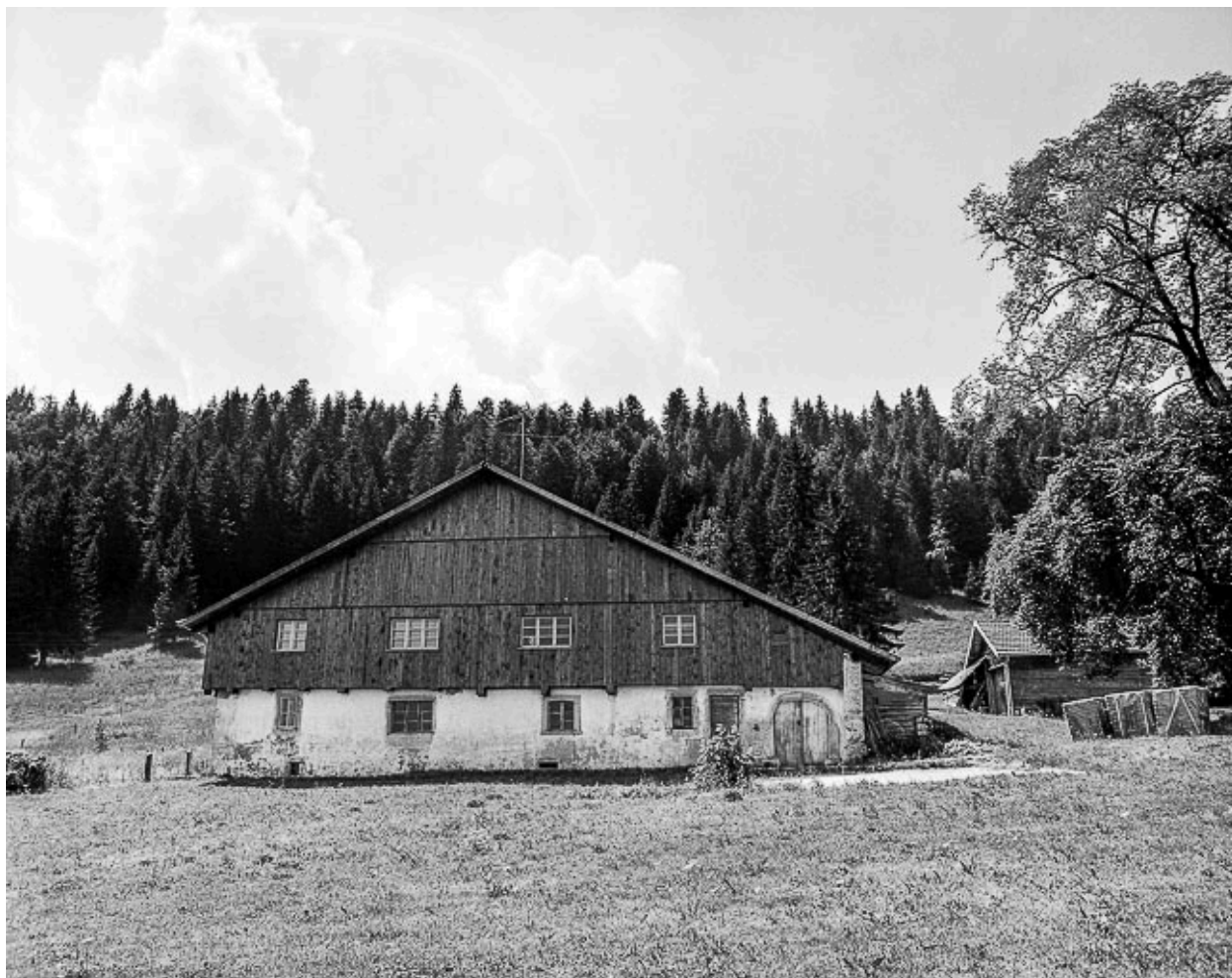
Ferme située au lieu-dit Ronde Sommette : façade antérieure.
