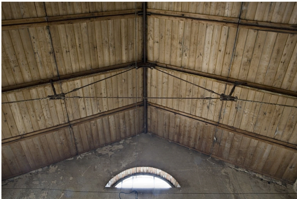
Atelier de réparation. Détail de la charpente Polonceau.
