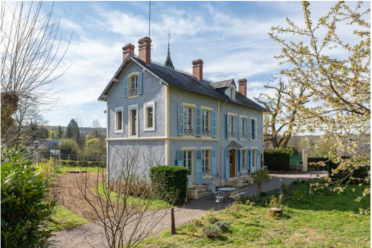
Façade nord-ouest et mur pignon nord-est.
