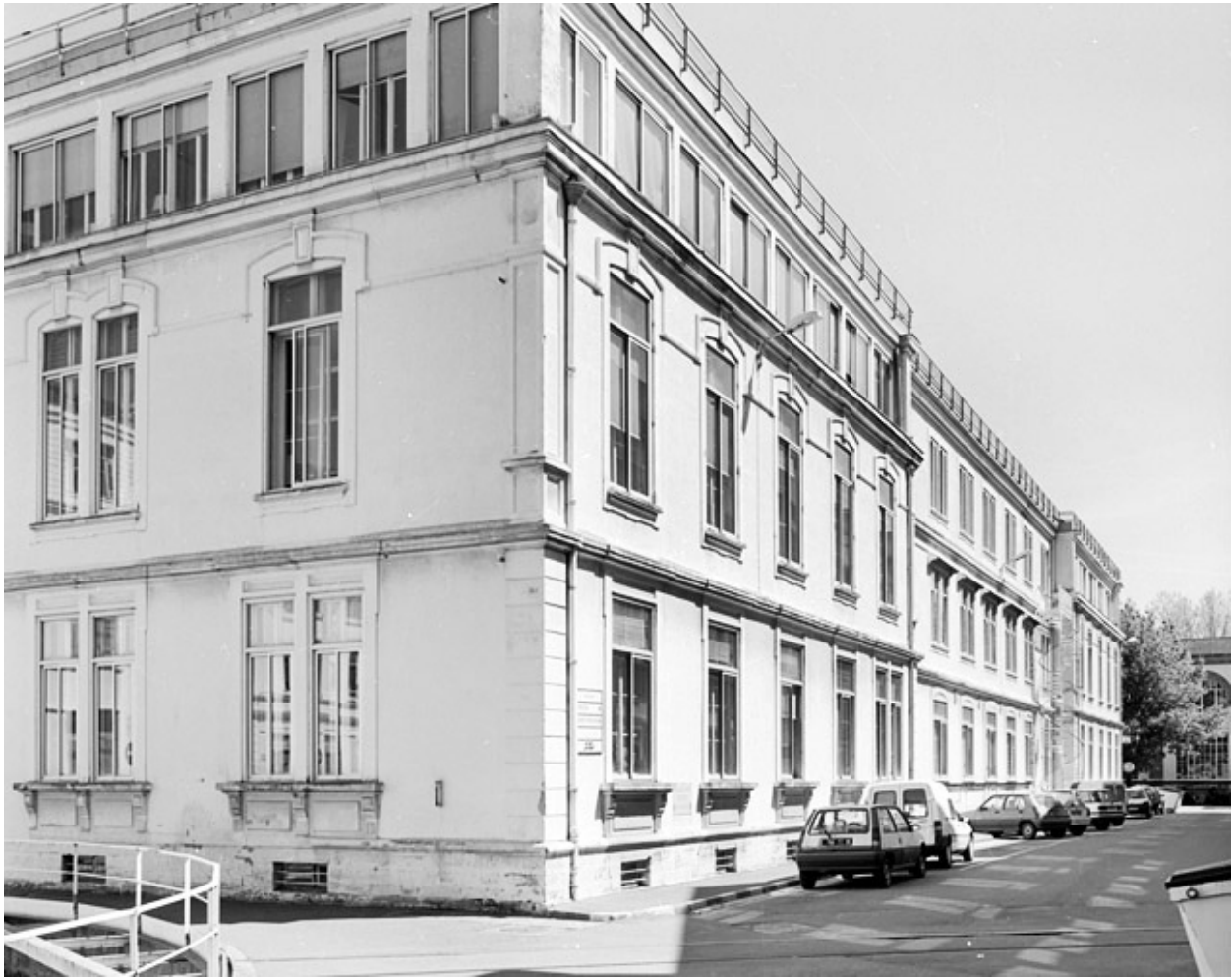
Vue de trois quarts des bureaux.
