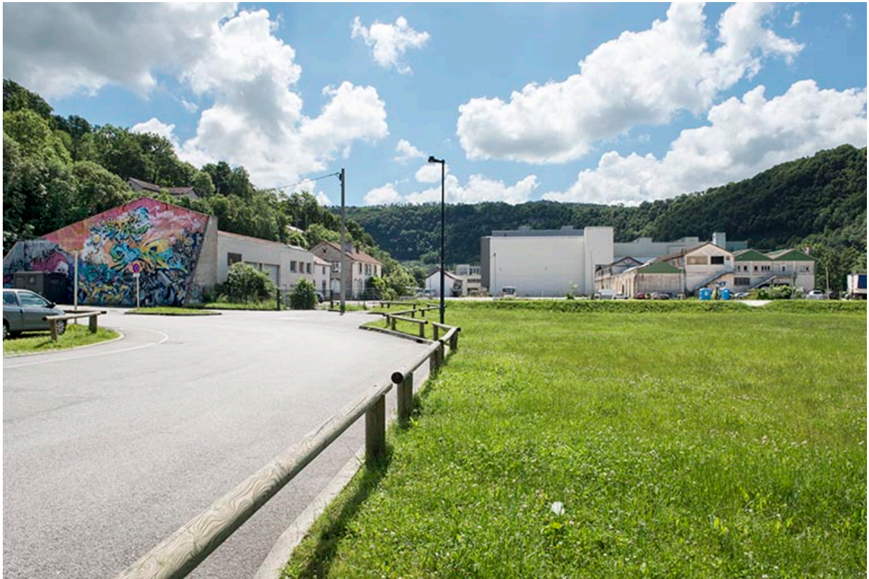
Etat en 2016. Usine B : vue d'ensemble, depuis le nord-ouest.
