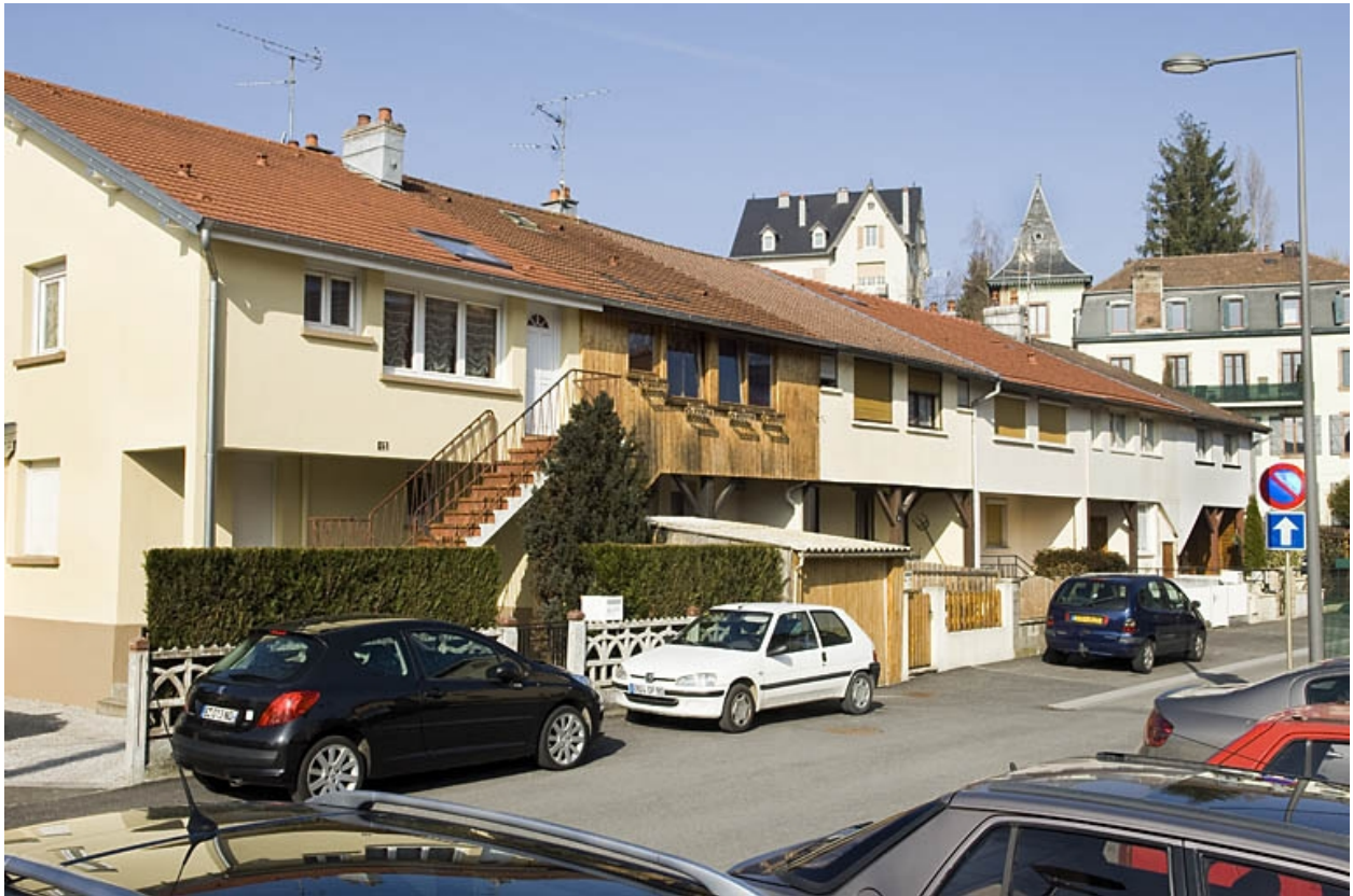
Façade sur la rue de Mulhouse.
