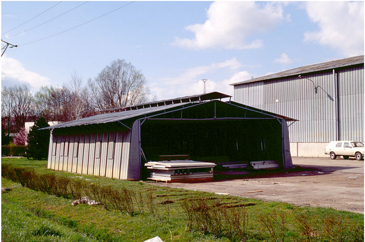
Entrepôt industriel (E).
