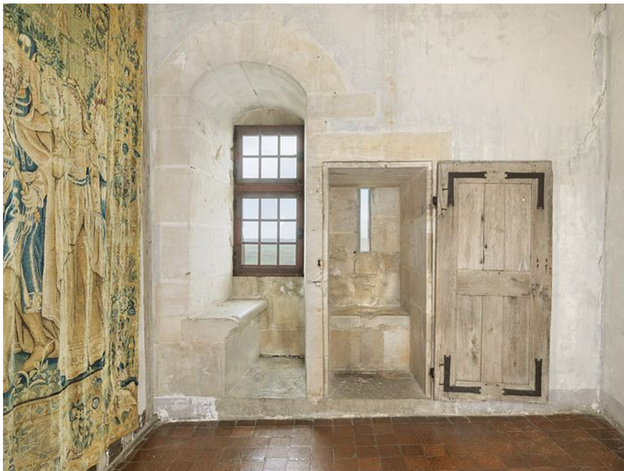
Appartement 15e siècle : pièce d'eau avec latrines et coussiège. Porte ouverte.
