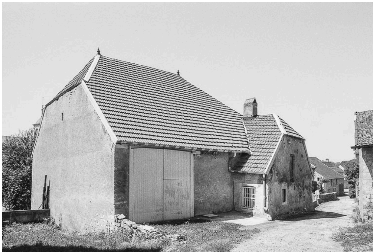
Valay, ferme située 1 rue Fénelon : exemple de ferme construite sur un terrain en pente avec écurie sous la grange.
