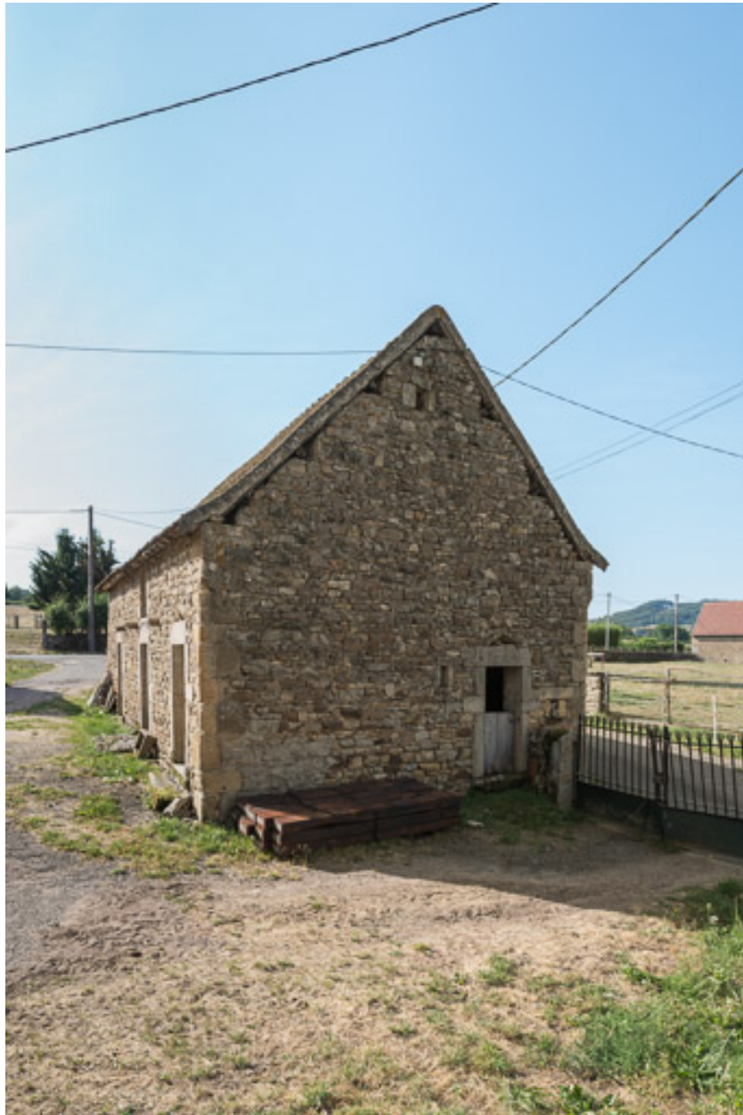
Mur-pignon ouest de la dépendance avec ses angles chanfreinés.
