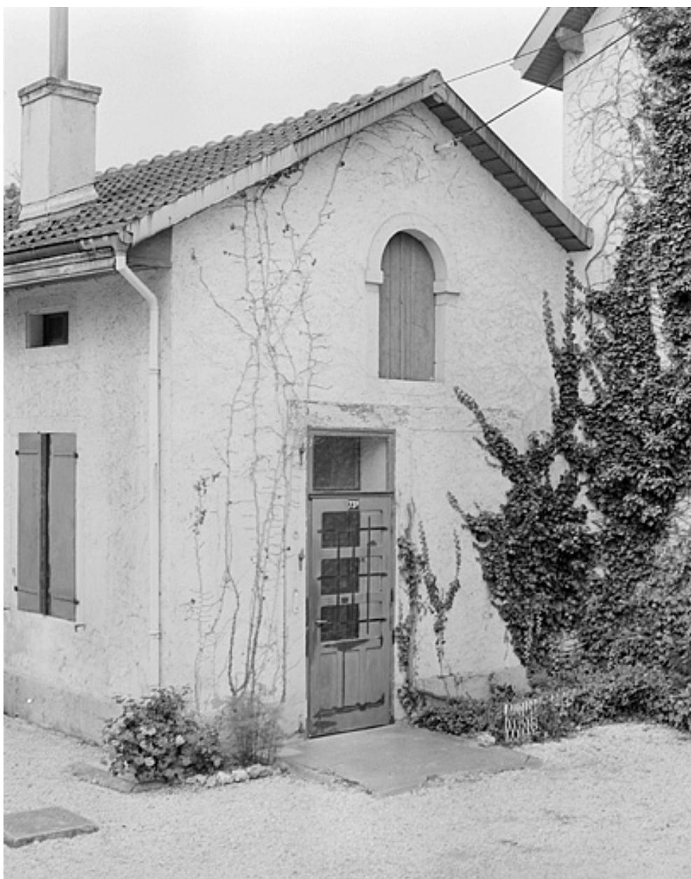
Anciennes écuries. Façade nord.
