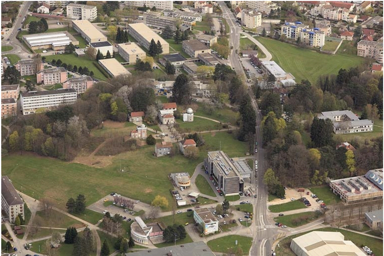
Vue aérienne du site, depuis l'ouest.
