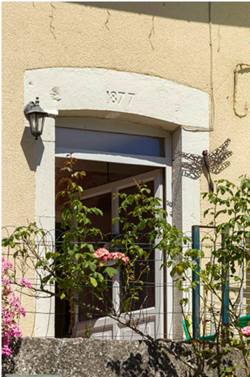
Date gravée au linteau de la porte d'entrée, écluse de Conflandey (70).
