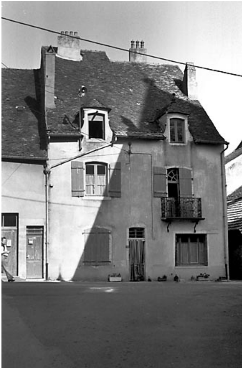
Maison située rue du Château.
