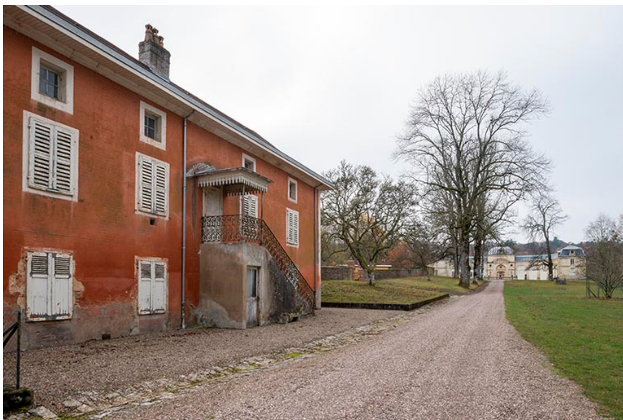
Façade nord, vue de trois quarts.
